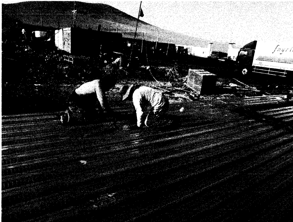
COLOCACION DE PLACA COLABORANTE CALIBRE 22
