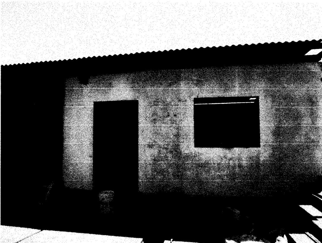
COLOCACION DE PLANCHA ONDULADA DE FIBRACEMTO PARA COBERTURA EN OFICINA Y DEPÓSITO
