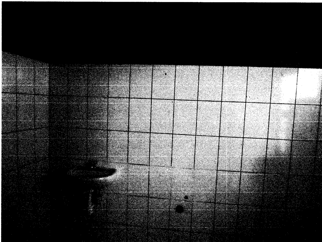
COLOCACION DE CERAMICO DE PARED Y LAVADERO DE MANO
