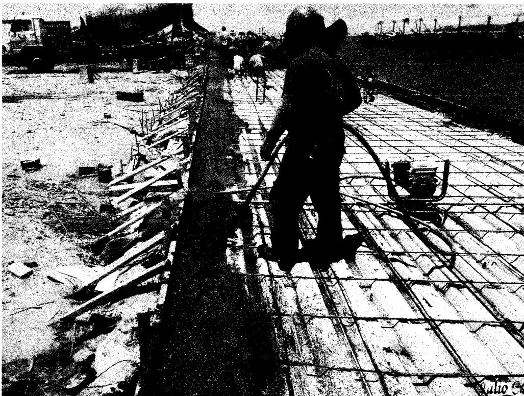
VACIADO DE CONCRETO 280 kg/cm 2 LOSA MACIZA EN MUELLE
